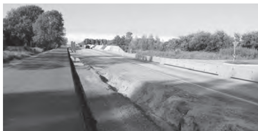
Ausbau B5, Höhe Süderfriedrichskoog, Blickrichtung Norden
