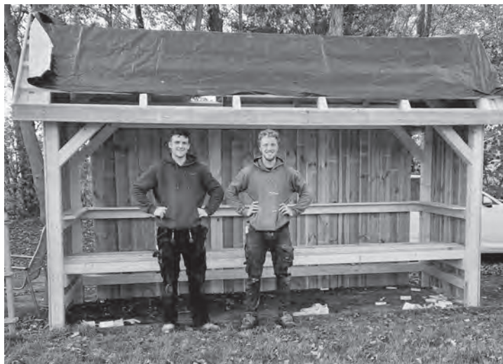
Henrik Cornils und Finn Pohns während der Arbeiten
